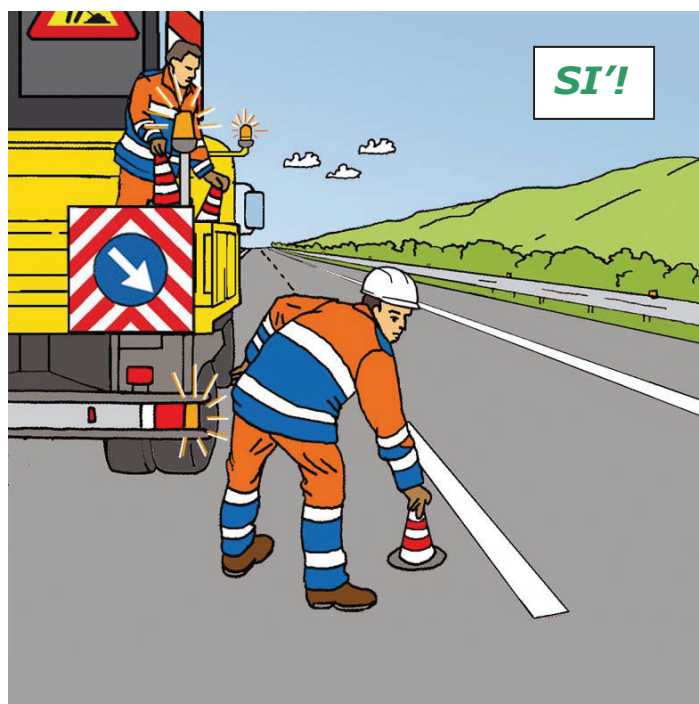
Figura 59 – Posizionamento dei coni o defleco: comportamento corretto
